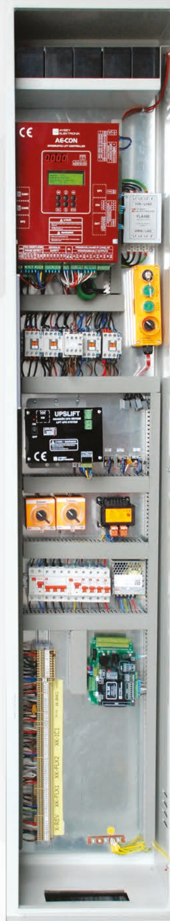
VVVF makine dairesiz kumanda panosu; AE-CON tümleşik sistem ile
